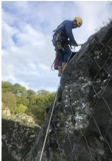
Figure 24. Pose d'un filet plaqué et ancré dans le massif rocheux.
