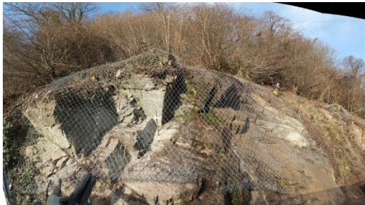
Figure 6. Filet plaqué et ancré.
