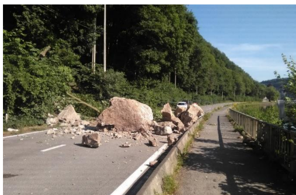
Figure 1. Effondrements rocheux survenus en 2017 sur la N96 à Anhée.
