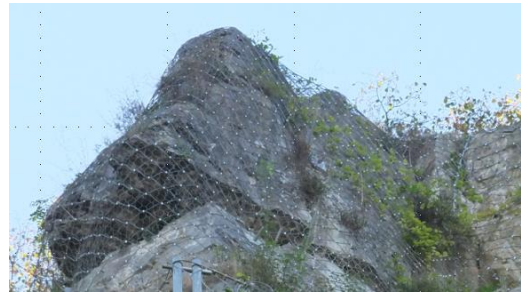
Figure 7. Filet plaqué et ancré.
