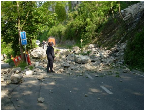
Figure 19. Effondrement d'une strate rocheuse sur la N647 en 2008.
