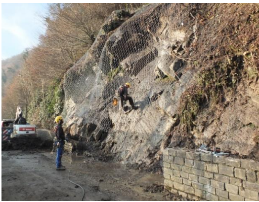
Figure 13. Effondrement d'une strate rocheuse : Filet plaqué ancré.
