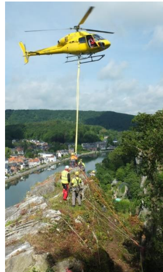
Figure 25. Acheminement du matériel de confortement par hélicoptage.
